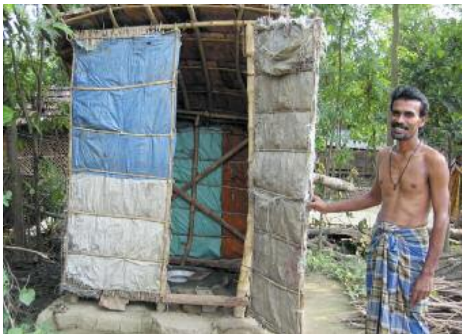
CI-DESSUS Utilisation de bambou et de plastique pour construire la superstructure alors que la structure inférieure est construite en dur. Colonie de Vidyasagar, Kalyani, Bengal Oriental, Inde.
