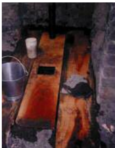
CI-DESSUS Utilisation de planches en bois pour la construction de latrines juste après le Déclenchement ; Maharashtra, Inde.
